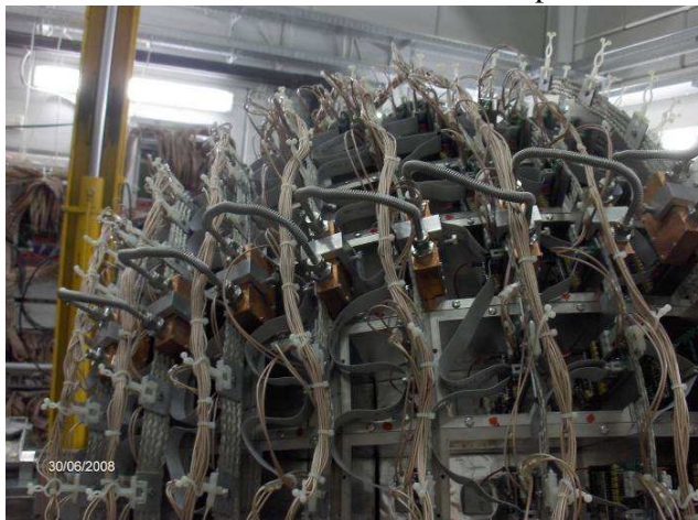
Fig.3 montaggio del nuovo sistema di
