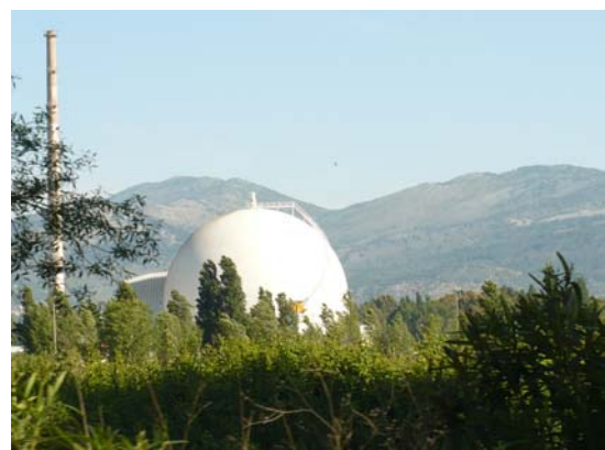
Figura 92 Vista esterna della centrale: camino e contenitore di sicurezza
