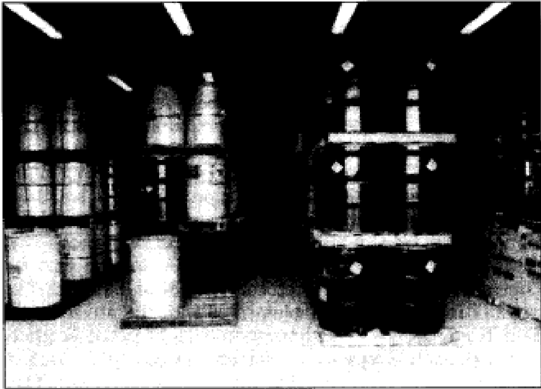
Fig 3.1 Tipico impianto di stoccaggio DOE (U.S.Department of Energy)
